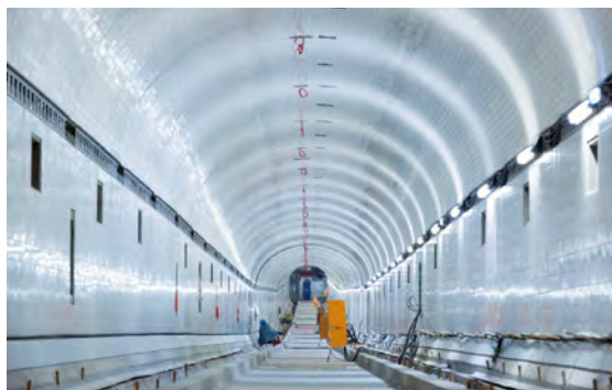
Foto: St. Pauli_Grundinstandsetzung St. Pauli-Elbtunnel_ ©Hamburg Port Authority
